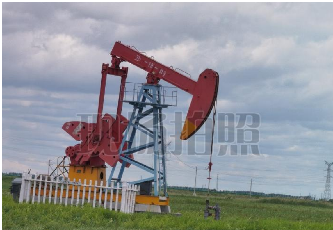
本项目区域内已建井现状
