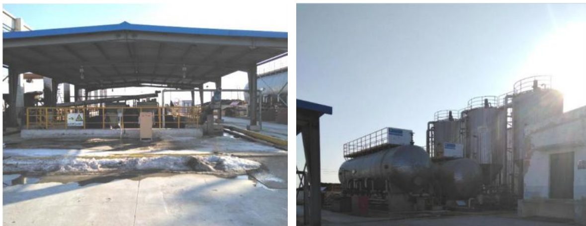
图 3.9-11 杏五二含油污泥处理站现状图
