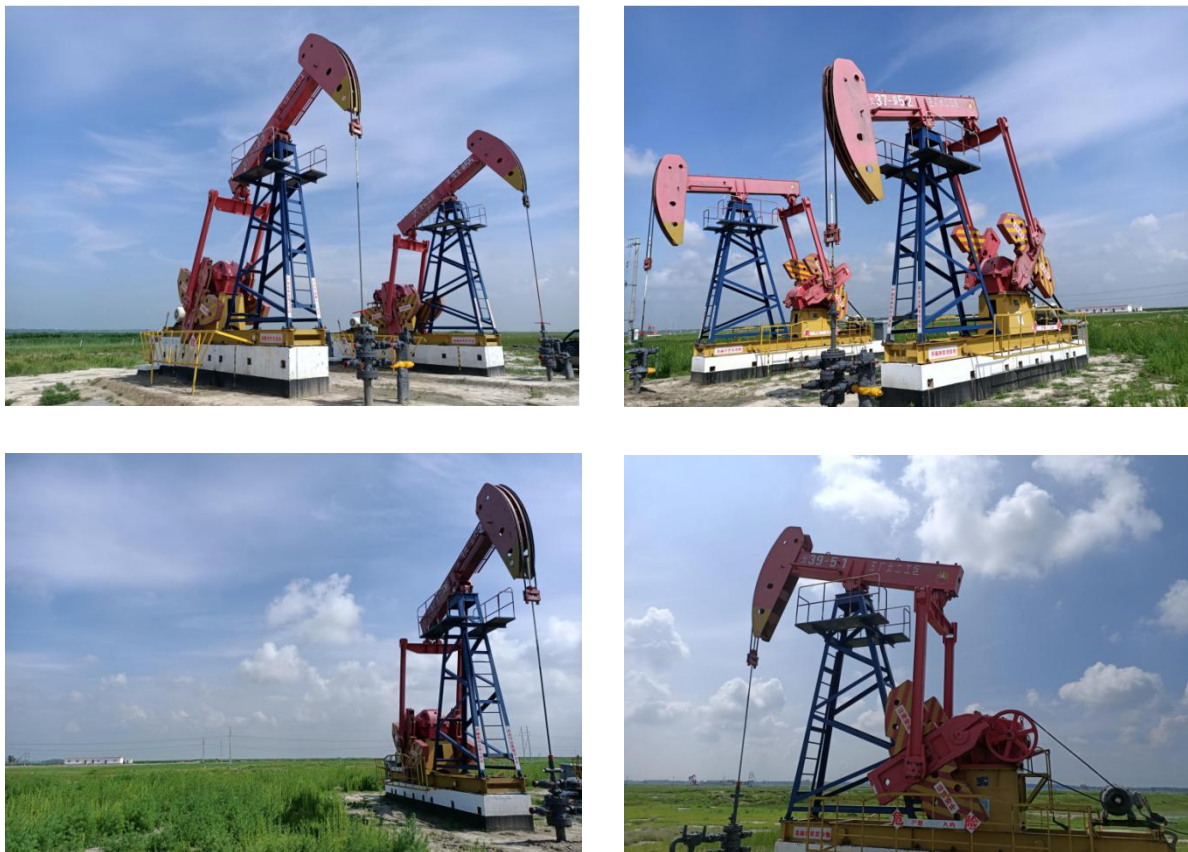
图3.1-1 太北开发区现有井场周边生态恢复情况
