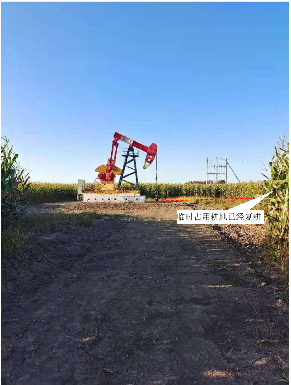
图 3-3 井场集油管线临时占地恢复现状
