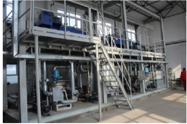
朝一联合含油污泥处理站厂房及加药间现状 朝一联合含油污泥处理站污泥离心处理装置
