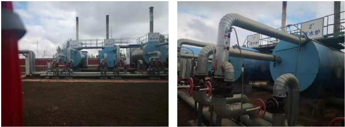
朝六联转油脱水站加热装置区现状
