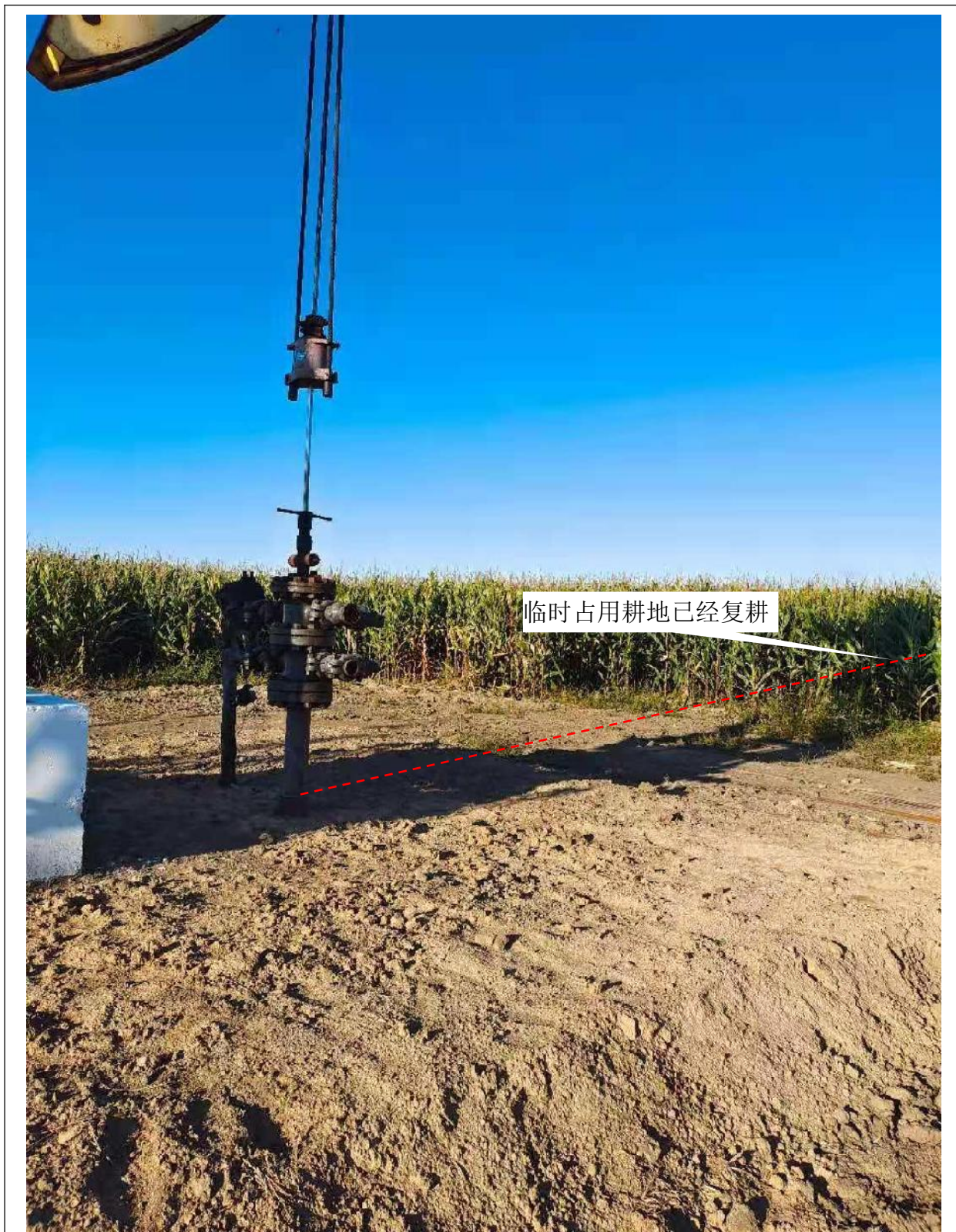
树 132-50 井场集油管线临时占地恢复现状
