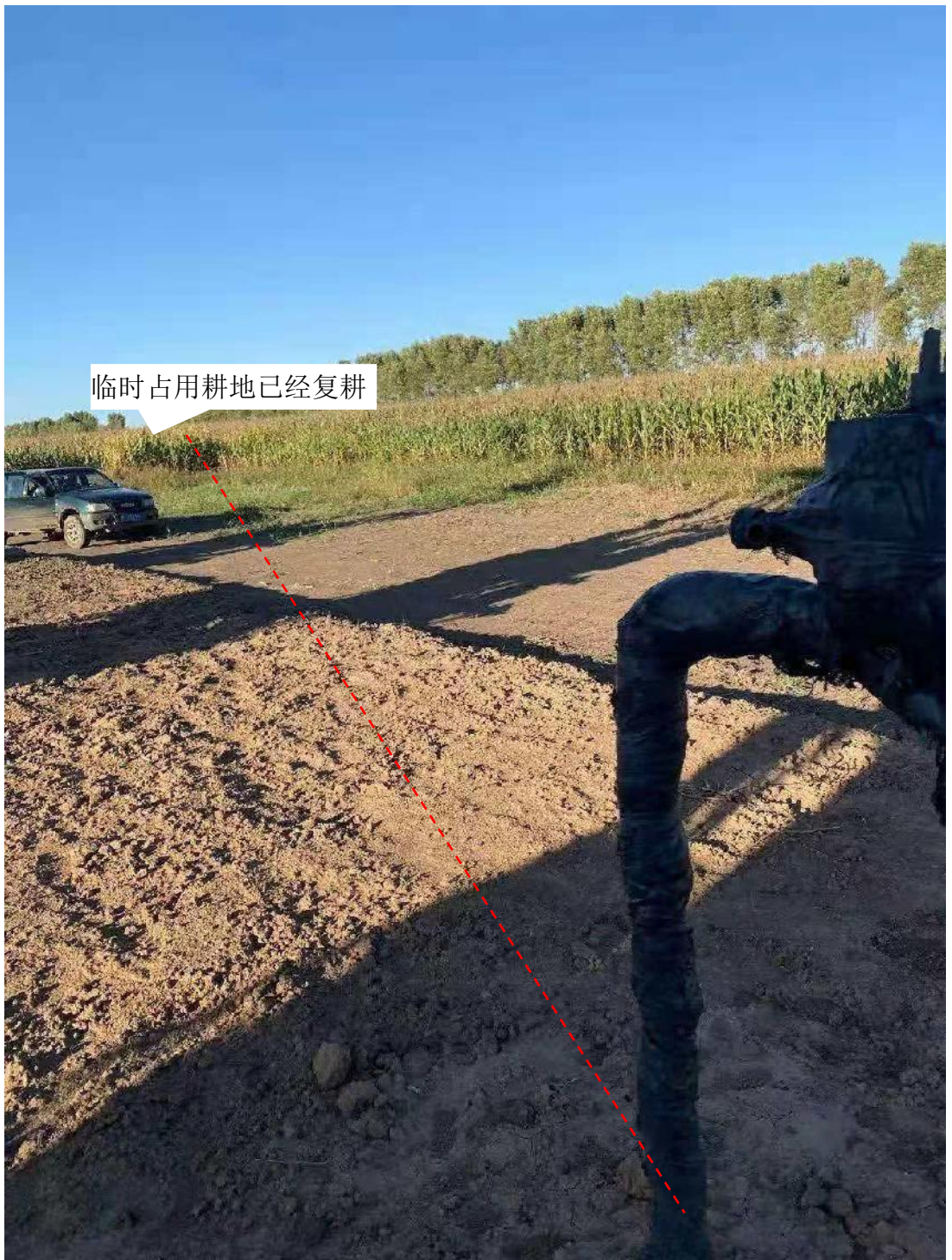
5号平台井场集油管线临时占地恢复现状
