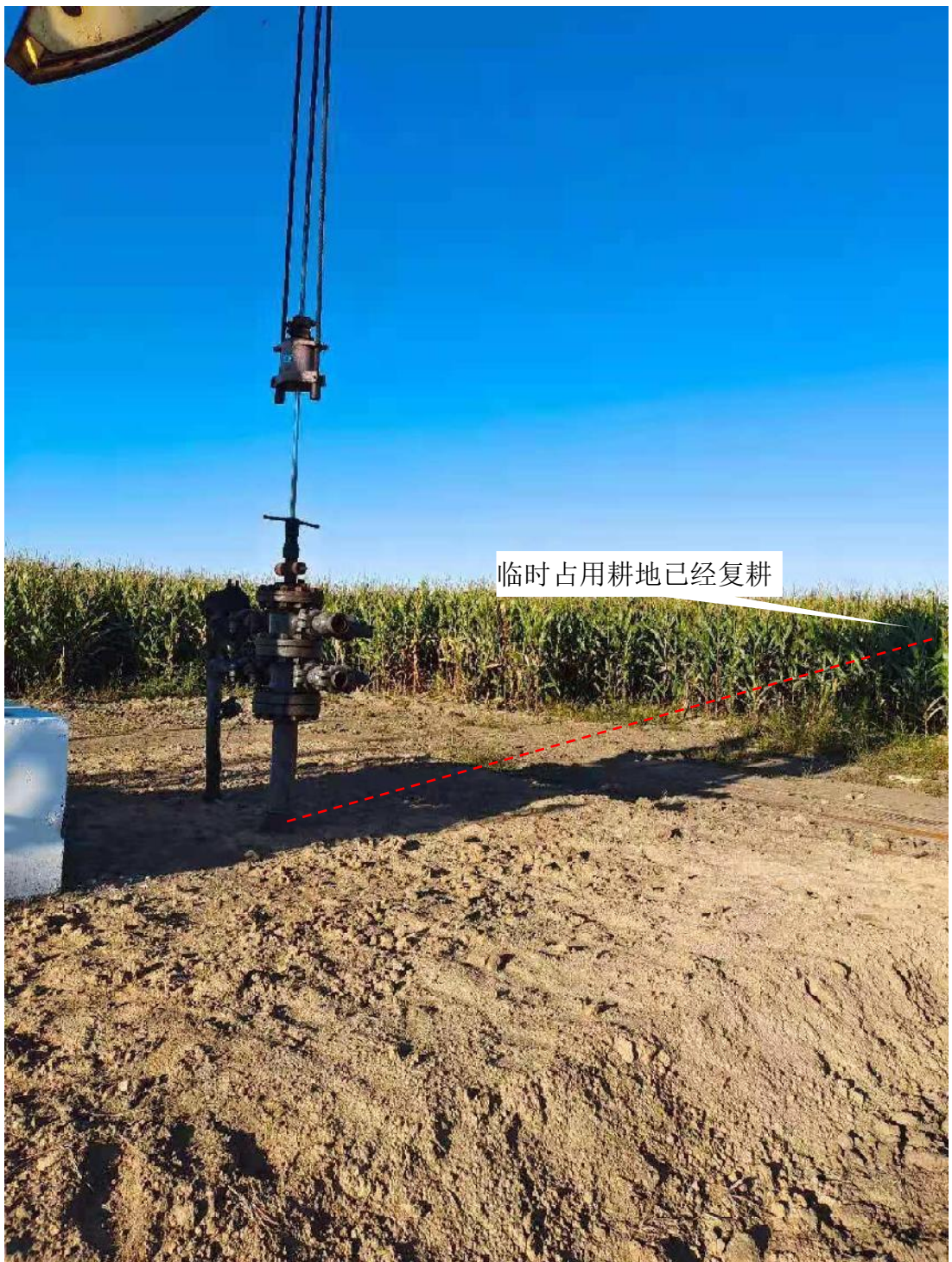
树 132-50 井场集油管线临时占地恢复现状
