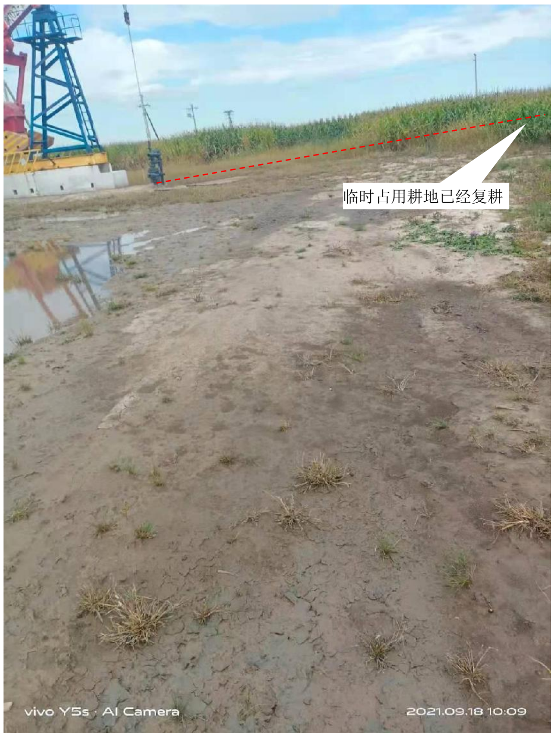
树 102-斜 82 井场集油管线临时占地恢复现状
