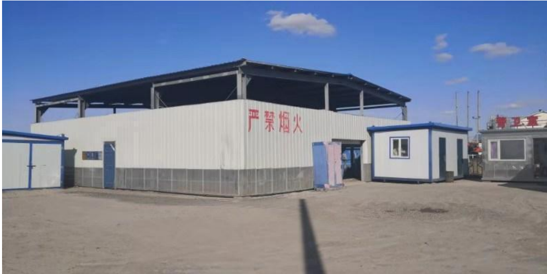
朝一联废压裂液处理站现状
