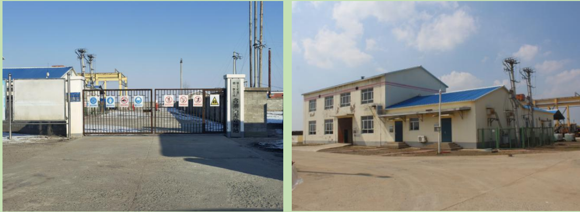
图 3.10-11 朝一联含油污泥处理站现状
