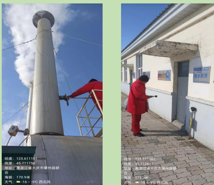
图3.10-5 朝一联脱水站站况现状
