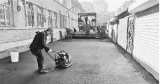
幸福胡同居民多幸福 4条城市巷道维修完成
