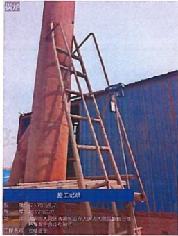
除尘器处理后
