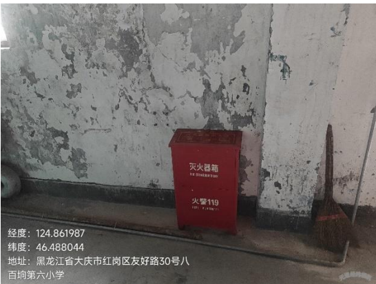
车间二灭火器箱
