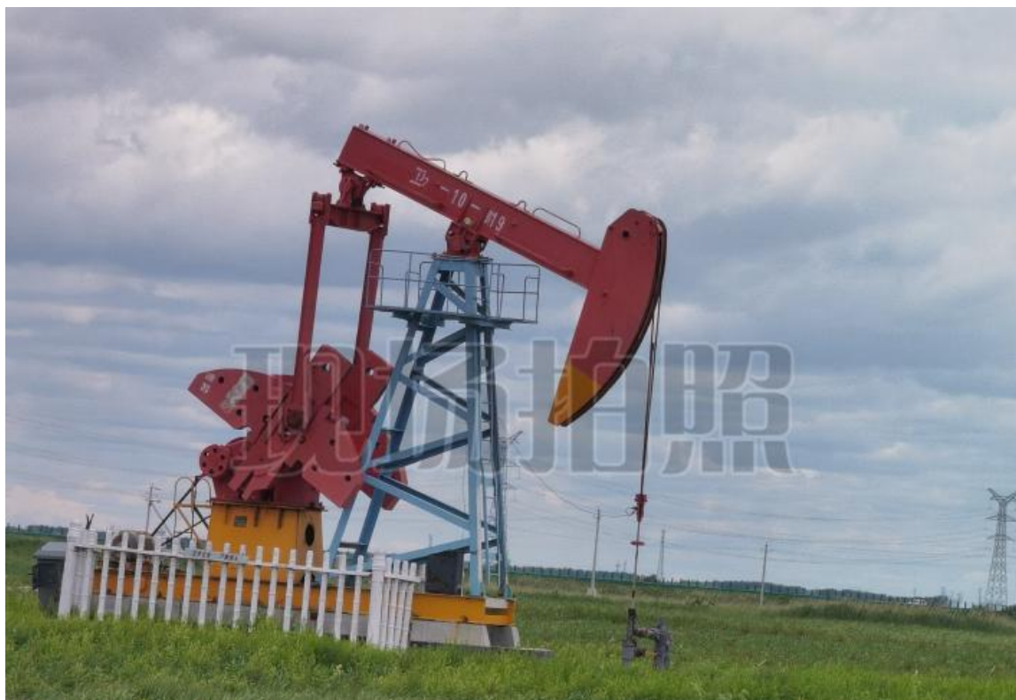
本项目区内已建井现状
