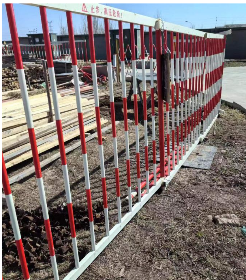
施工围挡标识设施
