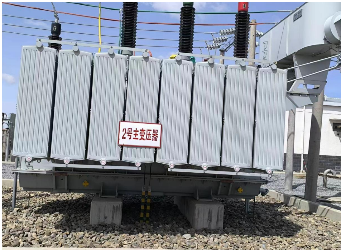
2 号主变压器建设情况
