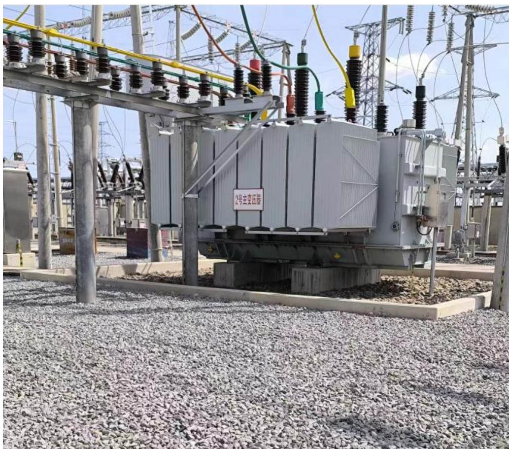
2 号主变压器建设情况
