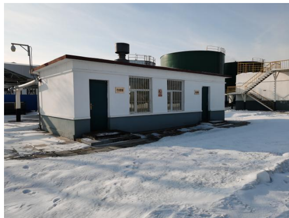
污水提升泵房
