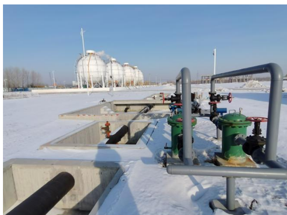
封堵作业坑、连头作业坑、放油坑
