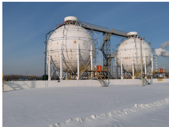
2 座模拟液氨储罐
