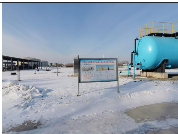
管道泄漏事故处置训练区
