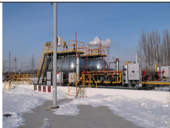
利旧 2 座 \phi 3200 \times 13386 轻烃储罐
