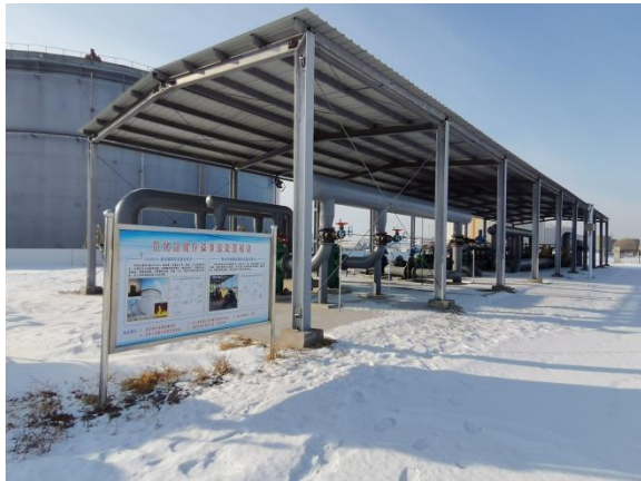
2000m 3 储油罐事故处置训练区
