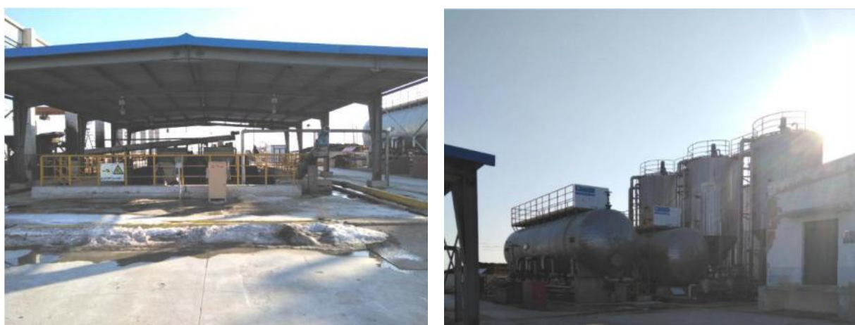
图3.8-10 杏五二含油污泥处理站现状图
