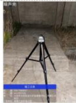
变电站厂界南侧
