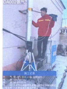
DA002 原料库排气筒
