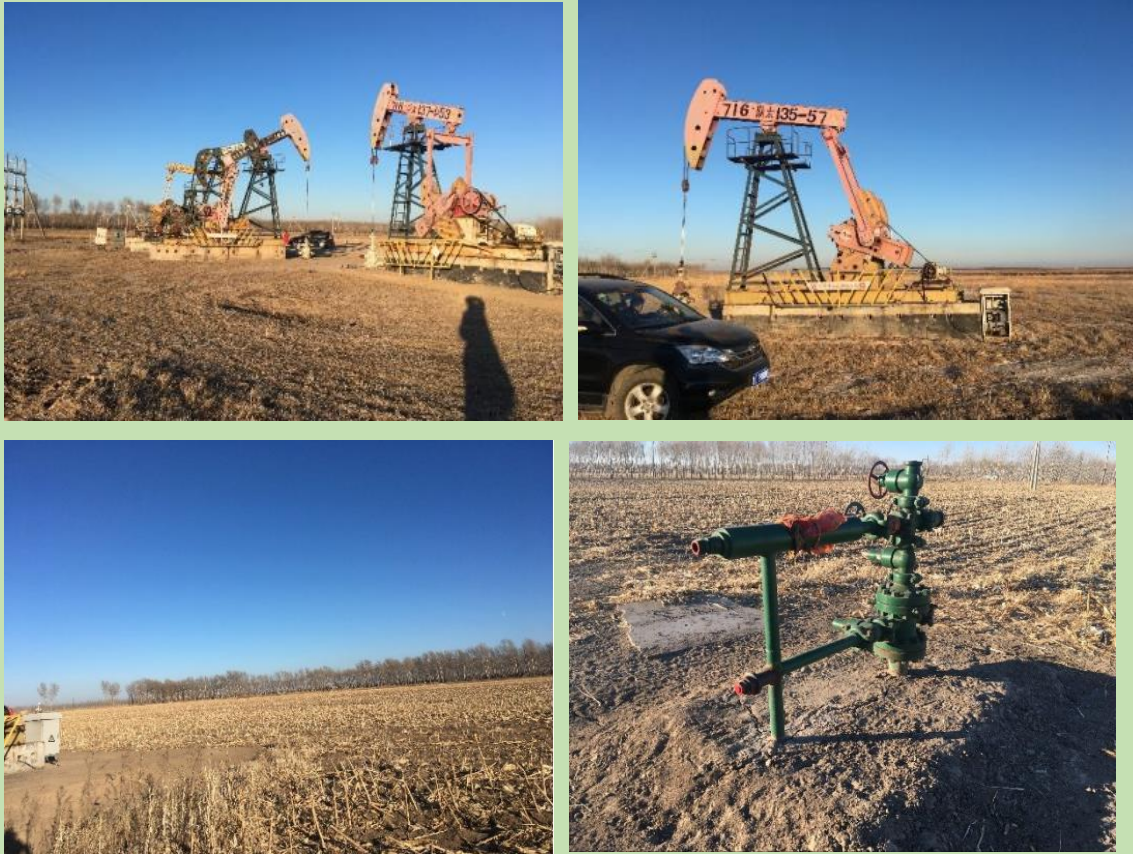
图 3.1-1 太南油田区块现有井场周边生态恢复情况
