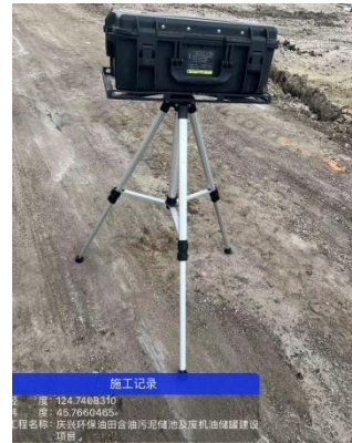
新建储池下风向
