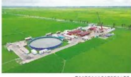
联合石化井下分公司大型压裂施工现场
