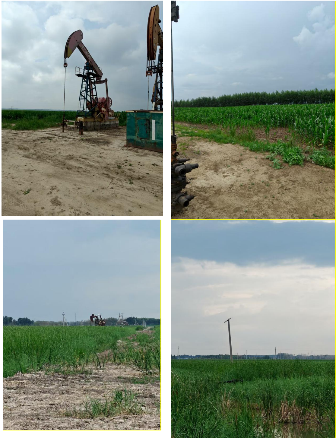
图 3.1-1 现有区块已建井场周边环境现状
