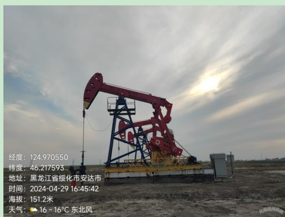
卫 2-46-27 平台井场恢复现状
