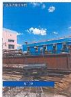
厂内清洗罐周围
