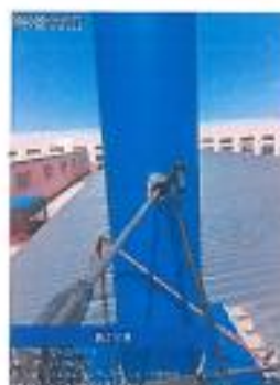
喷砂除尘废气排气筒 (DA001) 处理后
