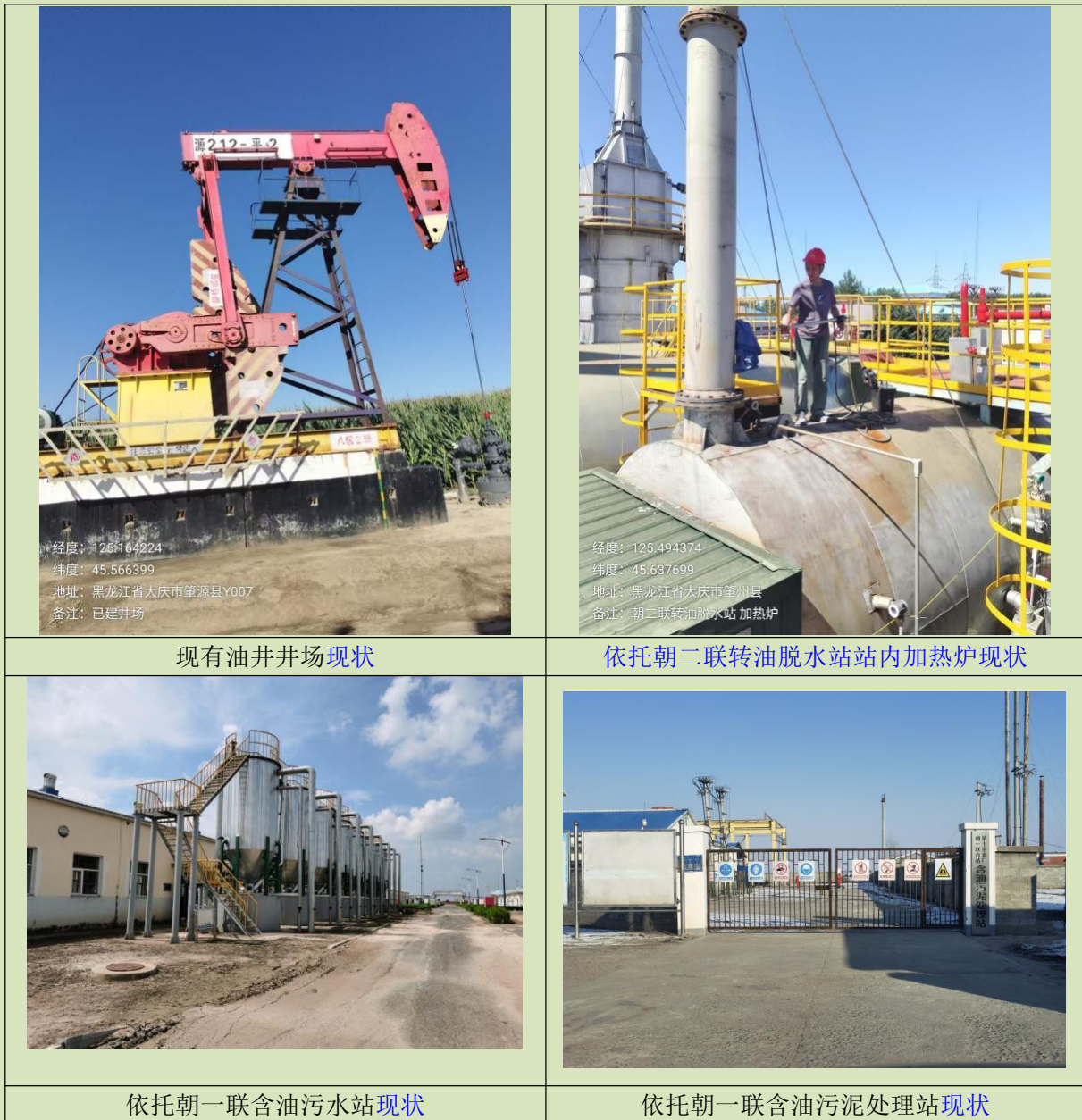
图 3.1- 1 朝 1-朝气 3 区块内井场及依托场站建设情况
