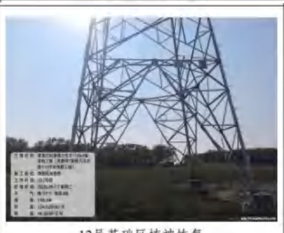
12号基础区植被恢复
