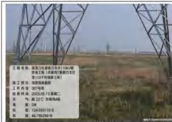
7号基础区植被恢复
