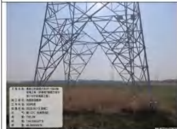
9号基础区植被恢复
