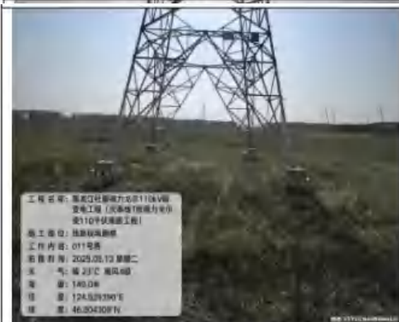
11号基础区植被恢复
