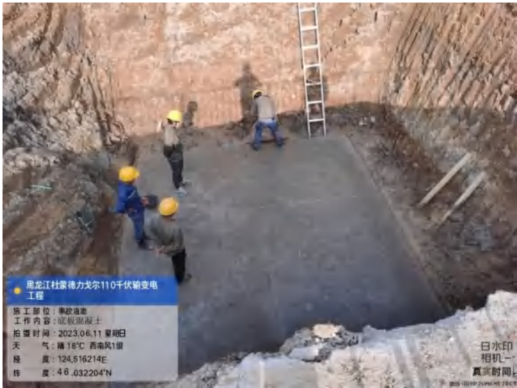
事故油池防渗施工
