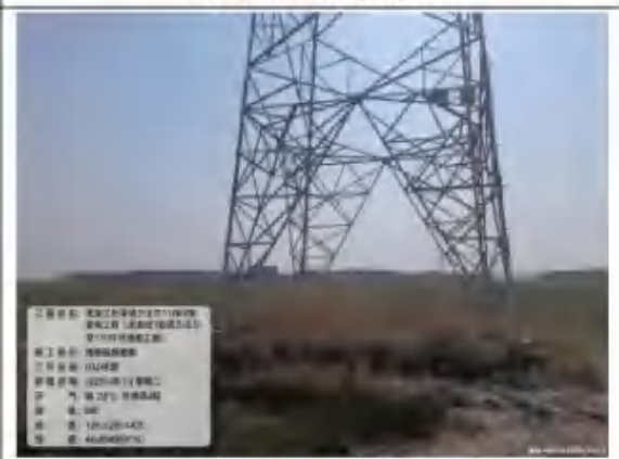
10号基础区植被恢复
