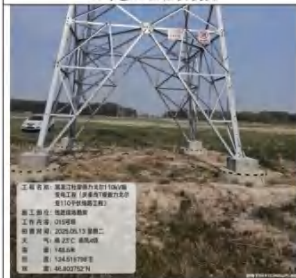
15号基础区植被恢复
