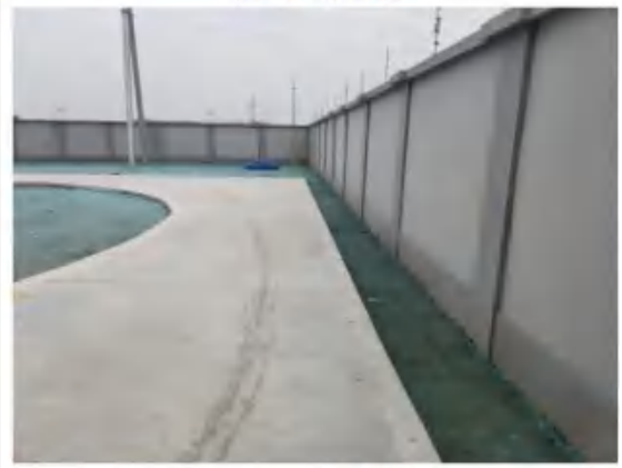
一体化雨水泵站
