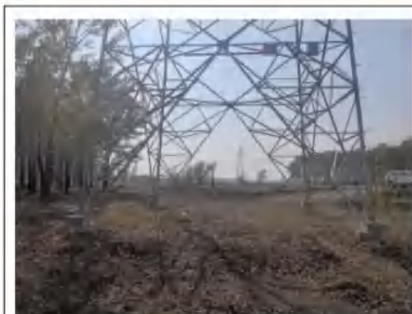
13号基础区植被恢复
