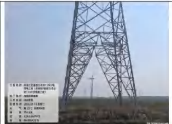
8号基础区植被恢复
