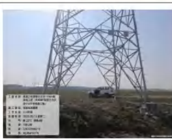
14号基础区植被恢复
