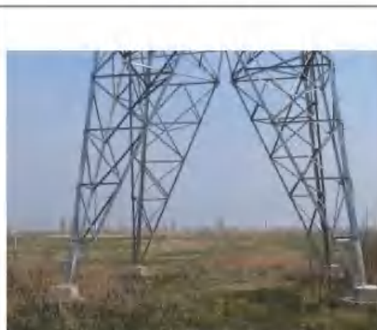
16号基础区植被恢复
