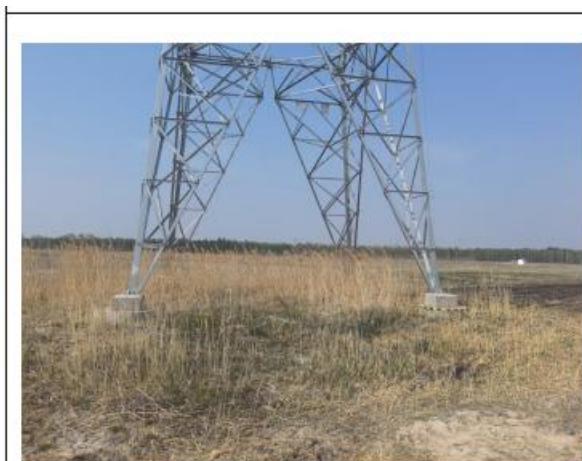
5号基础区植被恢复
