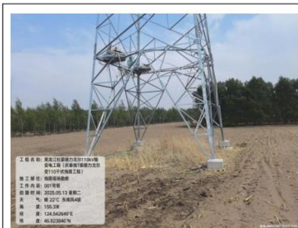
1号基础区植被恢复
