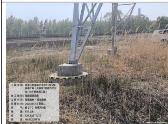
3号基础区植被恢复
