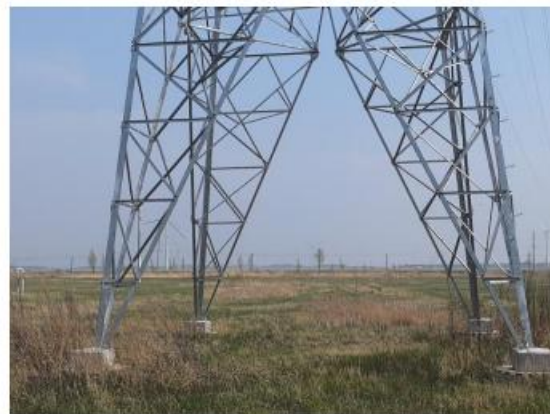
16号基础区植被恢复
