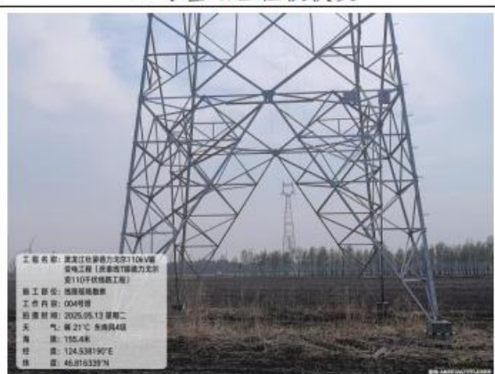
4号基础区植被恢复
