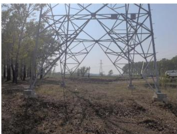
13号基础区植被恢复
