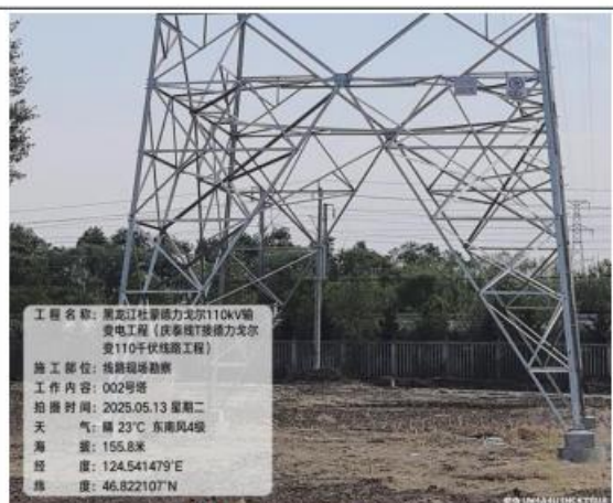
2号基础区植被恢复
