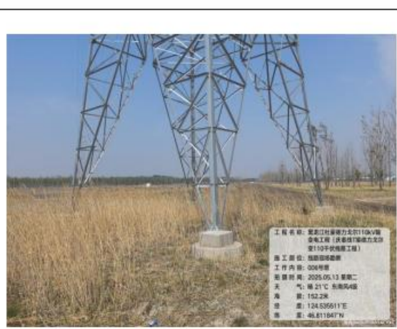
6号基础区植被恢复
