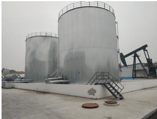
驱油型冲洗液储罐和围堰
