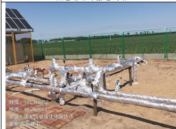
管道衔接地面场地汇管
