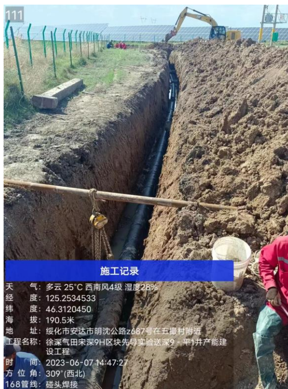
图 4-2 输气管道现场敷设情况
