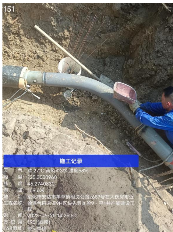
图 4-1 输气管道现场焊接图
