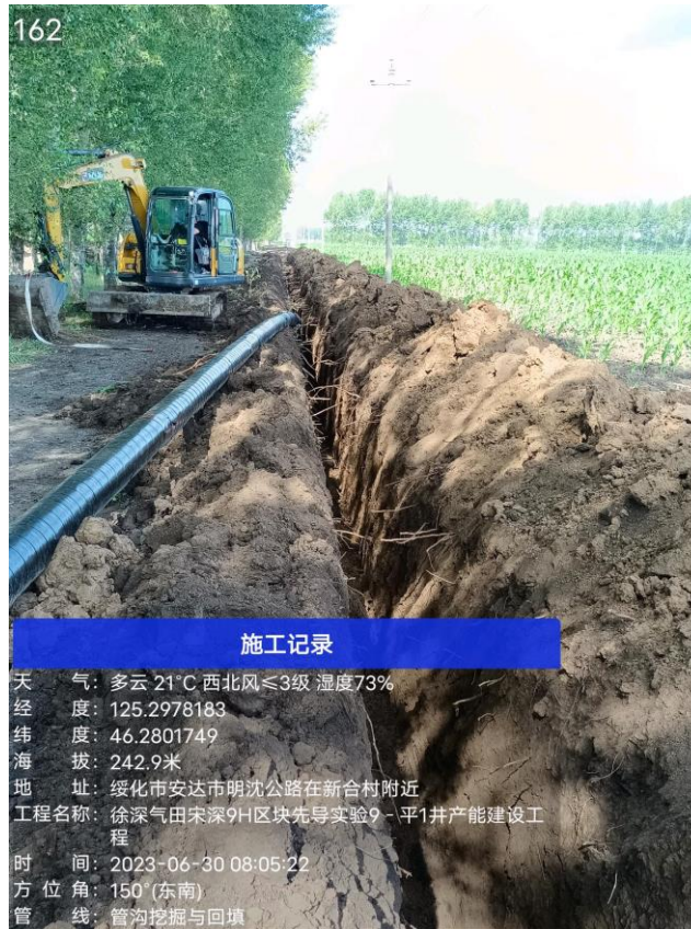
图 4-4 输气管线管沟开挖表土单独堆存现场照片
