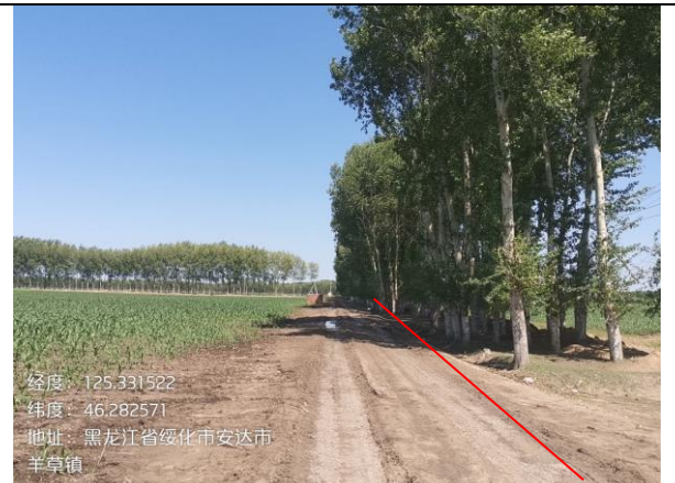
宋深 9-平 1 至衔接场地采气管线（中途进井路南侧段）
