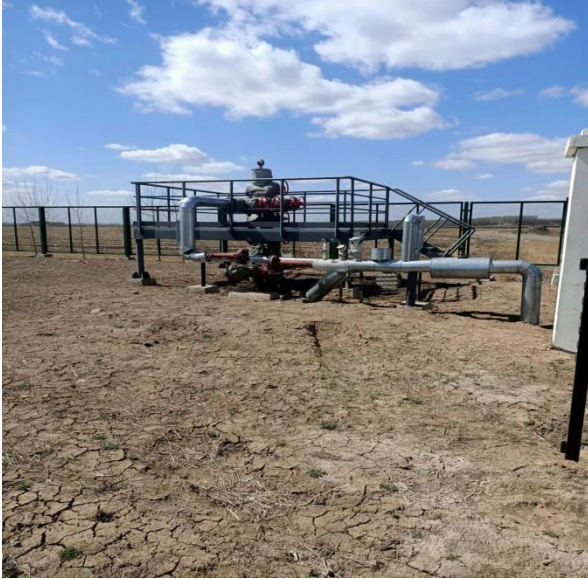
四库 1 井场恢复现状
