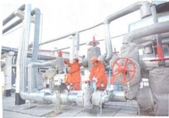
这是采油十厂第二作业区党员先锋岗党员王立（左）正在检查设备运行情况。该党员先锋岗是“党建红”引领“通勤蓝”工程的一个缩影，通过党员的先锋模范作用，推动了油田高质量发展。
