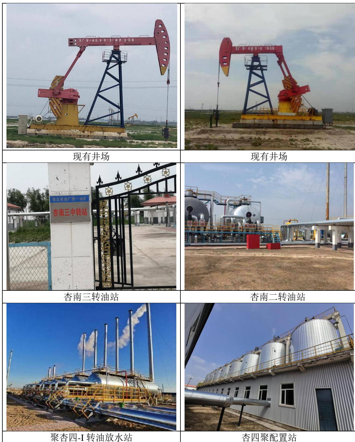
图 3.1-1 杏八区纯油区内井场及场站建设情况
