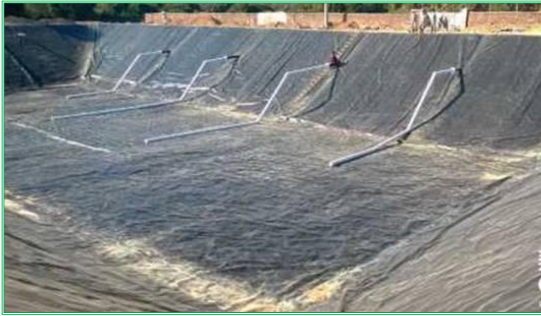
图 6.2-4 黑膜厌氧池内部示意图
