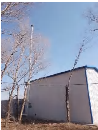
危废贮存库活性炭吸附+15m高排气筒排放
