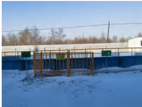
初期雨水收集池
