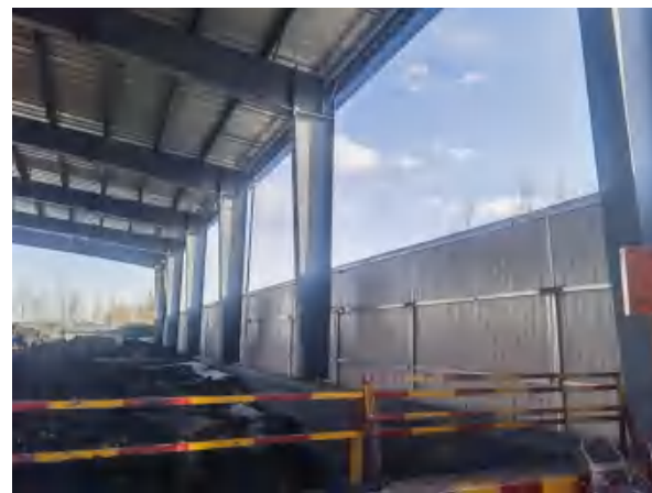
含油污泥暂存池
