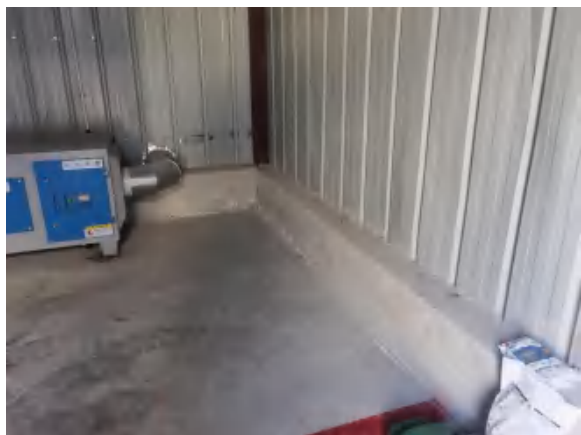
危险废物贮存库裙角
