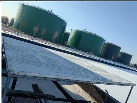
废液储存池设置放密闭棚盖
