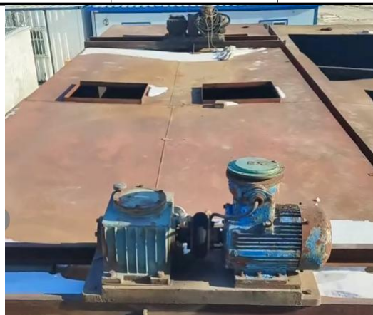
废液储存池设置盖板
