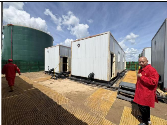
污水处理装置
