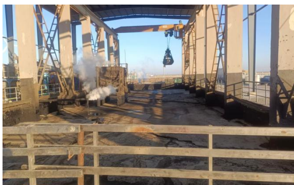
含油污泥存储池
