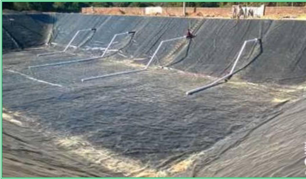
图 6.2-3 黑膜厌氧池内部示意图
