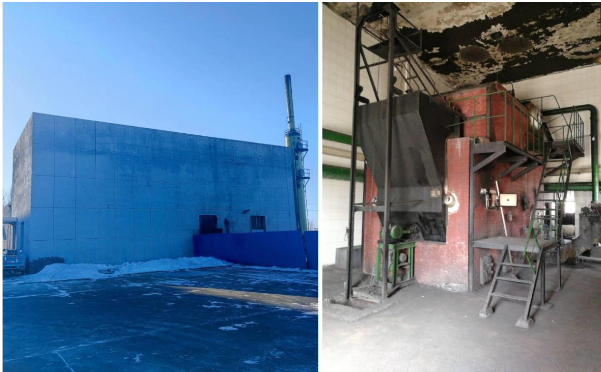
图 3.1-3 锅炉房外观及燃煤锅炉现状图
