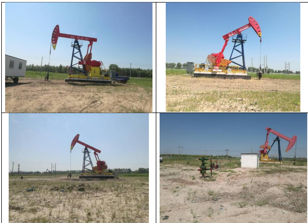
图 3.1-2 萨北开发区北部过渡带二条带西区内井场建设情况
